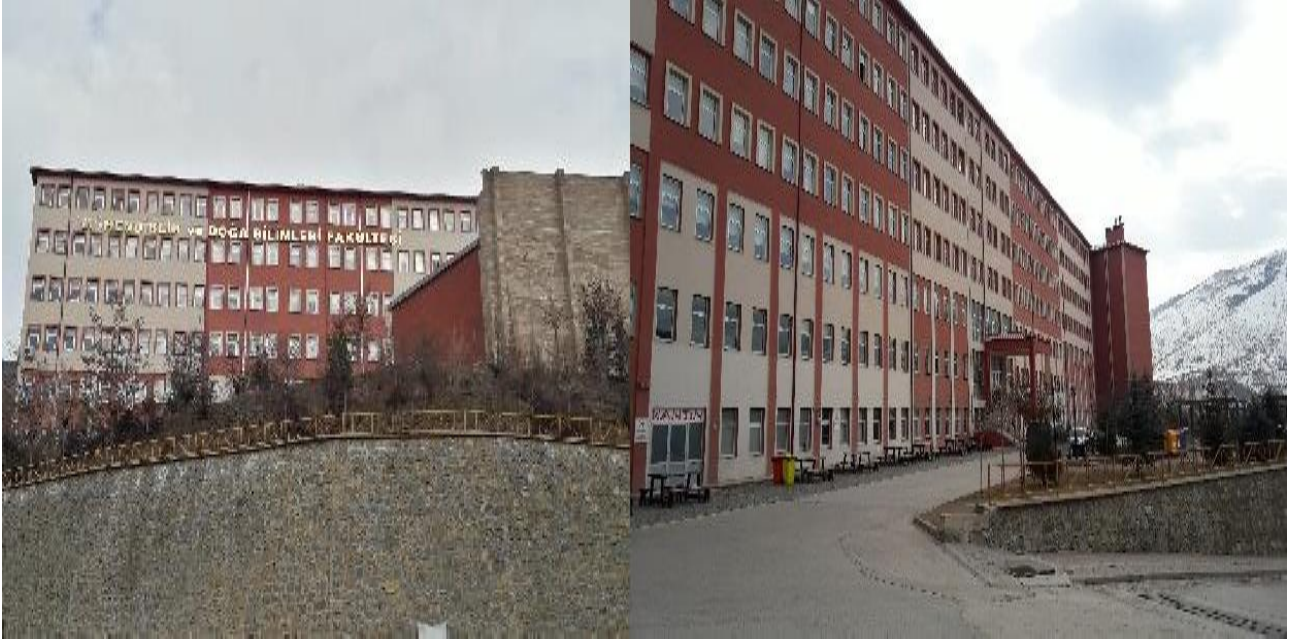
Şekil 2. Fakültemiz Hizmet Binasına Ait Bir Görünüm
