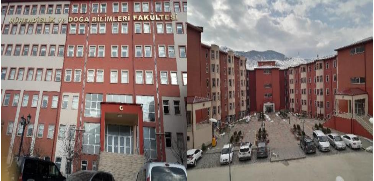
Şekil 1. Fakültemiz Hizmet Binasına Ait Bir Görünüm
